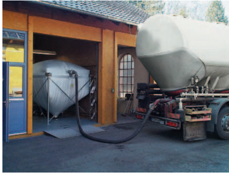
Bild 5: Die Lieferung der Pellets erfolgt in Tankwagen.
